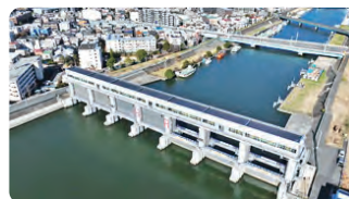
今井水門耐震補強工事 事業記録 平成27-令和3年度、5年度 東京都江東治水事務所 (株)丸島アクアシステム
